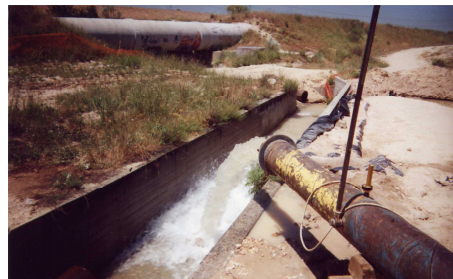
Figura 5.-Aforador y tubo pitot para medición de caudales.
