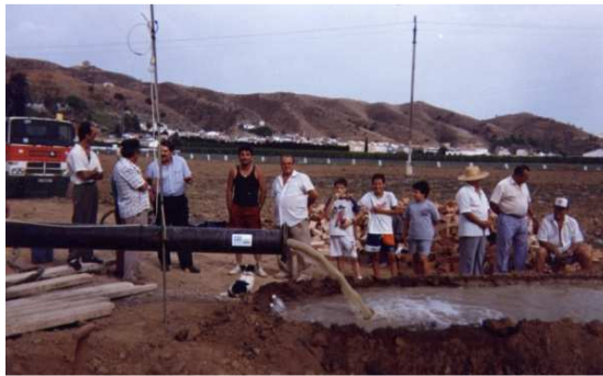
Figura 2.-Limpieza de pozo durante la fase de aforo escalonado.
