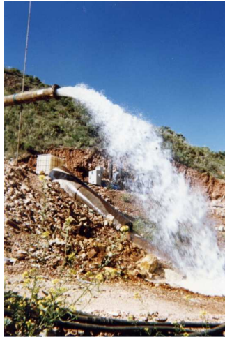
Figura 7.-Descarga directa de un ensayo de bombeo a cauce superficial.
