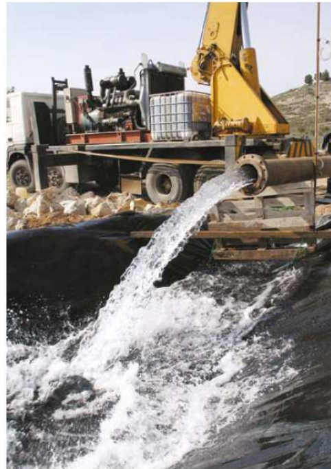
Equipo de ensayo de bombeo
